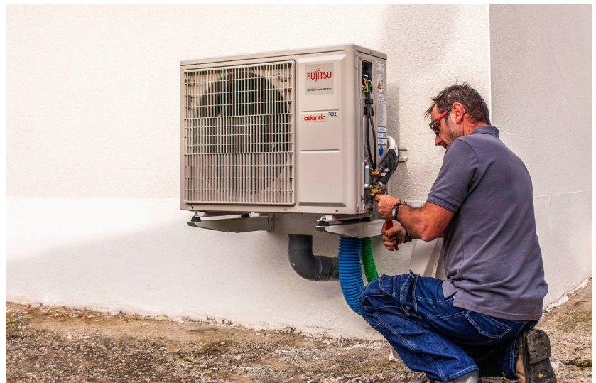
Installation de l'unité extérieure !
